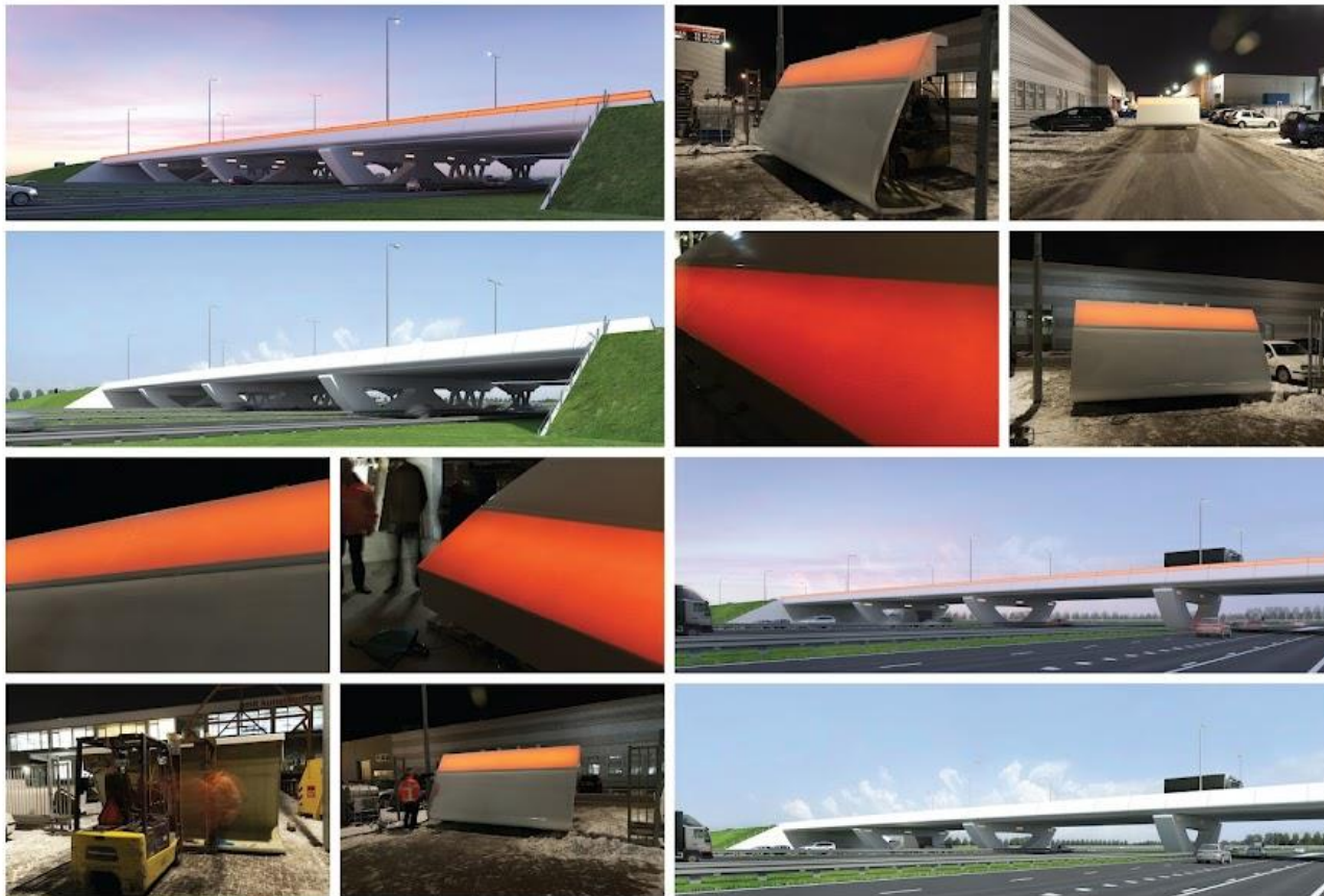
Kunstwerken in de provinciale weg N201 over de Rijksweg A4 nabij Schiphol | met compositie translucente brugranden Provincie Noord-Holland
